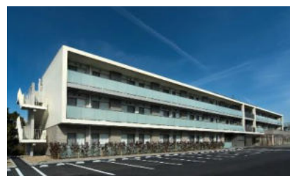
施工例 野庭風の丘(特別養護老人ホーム)
