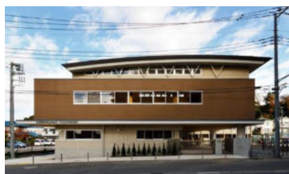
施工例 飯島東幼稚園
