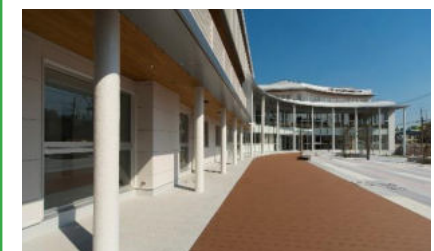
施工例 聖灯看護専門学校
